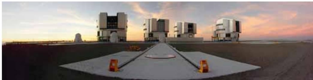
*faisceaux lumineux issus de chaque télescope parcourent d'abord une centaine de mètres dans un tunnel souterrain jusqu'à un instrument qui va les mélanger. Pour obtenir un cliché, il faut être capable de contrôler le trajet de la lumière au micromètre près* ». L'atout de Pionier? Ses concepteurs l'ont équipé d'une puce en silicium capable de diriger très finement la lumière là où les instruments antérieurs nécessitaient tout un jeu de miroirs très difficiles à ajuster.
