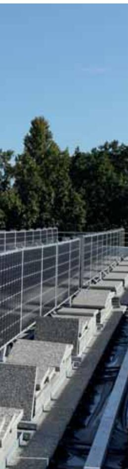
01 La partie supérieure de la façade sud du bâtiment Adream, faite de vitrages et de panneaux photovoltaïques, a été conçue pour tester de nouvelles technologies.
