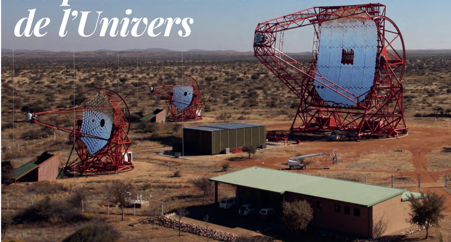
Depuis la Namibie, le réseau de télescopes Hess scrute les gerbes électromagnétiques produites par la désintégration dans l'atmosphère des rayons gamma venus de l'espace. Issus d'événements cataclysmiques, leur énergie est sans commune mesure avec ce que l'on est capable de reproduire au sein des plus puissants accélérateurs de particules.
