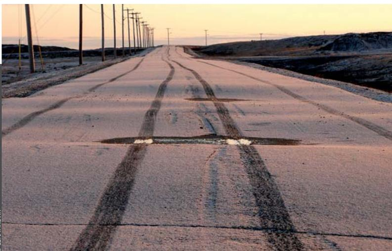
Déformée par le dégel du pergélisol, la route d'accès à l'aéroport d'Akulivik, dans le nord du Nunavik, a dû être réparée.
